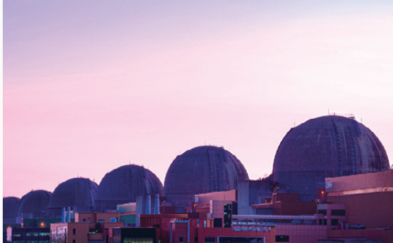
한빛6호기SG2차측In-Bundle 정비보조공사 공사비 : 100,611천원
