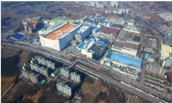
SK 하이닉스 M14 PH-2 PJT 2~3공구
