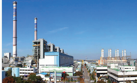
기력 2,3호기 현장계측제어설비 정밀점검공사 공사비 : 107,953천원
