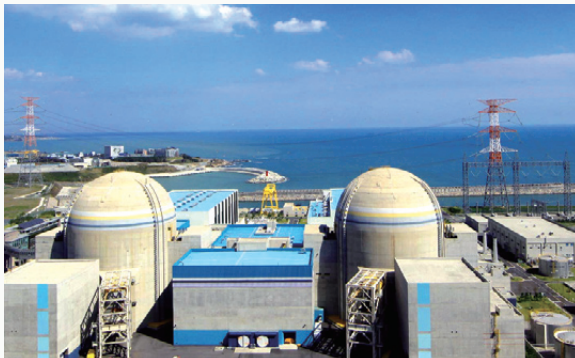
고리 3,4호기 EQ 후속조치 공조설비 환경개선 계측공사 공사비 : 720,175천원
