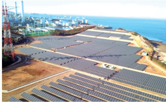
당진에코파워 태양광 발전설비 / ESS
